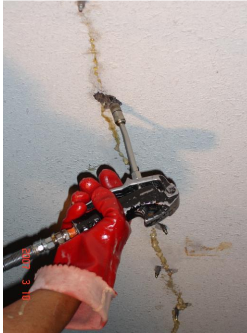
Inyección de grout de poliuretano
